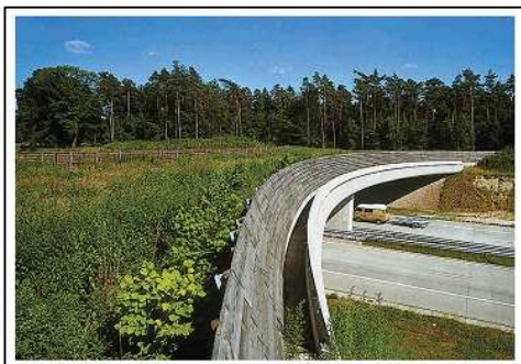
Foto 20. Ülepääsul Boerskottenis, Hollandis, on piirdena kasutatud suletud puittara. Piirded on ülepääsul paigutatud nii välisse serva kui võimalik, ja kaldega ülepääsu poole, et laiendada võimalikult loomade liikumisala. Lisapiire ja rada väljaspool loomaülepääsu piiret on mõeldud ohutute hooldustööde tegemiseks Foto autor H. Cormont.
