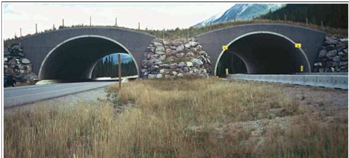
Foto 23. Loomade ülepääs Banff'i rahvusparkis üle Trans Kanada kiirtee rajati valmismoodulitest ja paigutati eraldi lahendusena olemasolevale kiirteele (Foto autor H. Bekker).
