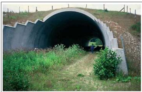
Foto 33. Fotol olev läbipääs Taanist on diameetriga 13 meetrit, 8 m kõrge avaga ja 87,5 m pikk (läbipääsu peal) ja 115 m pikk (läbipääsu sees). Seda läbipääsu kasutavad regulaarselt nii rebane, mäger, nugis, kärp kui ka tuhkur, aga ka inimene ja hobune. Sõraliste jaoks on sellise läbipääsu avatuse indeks liialt madal. Kiirteede alt kulgevatel läbipääsudel peab teekatte ja läbipääsu vaheline pinnasekiht olema piisav et summutada kiirteeliikluse müra ja vibratsiooni ( Foto autor B. Wandall ).
