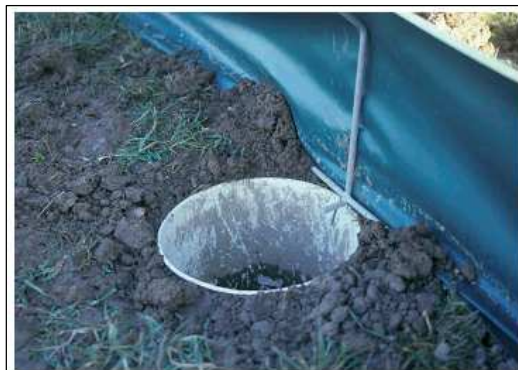
Foto 38. Ajutine piirdelahendus ja konnade kogumise ämber selle taga. Ämber kaevatakse maasse ajutise piirde taha selliselt, et konnad ei saaks sellest piirdepoolsest küljelt mööduda. Konnad, kes juhitud magnetjoontest, püüavad end piirde vastu surudes ja piki seda liikudes sellest mööduda, kukuvad ämbritesse ja neid saab sellega üle tee aidata ( Foto autor: P. Schlup ).
