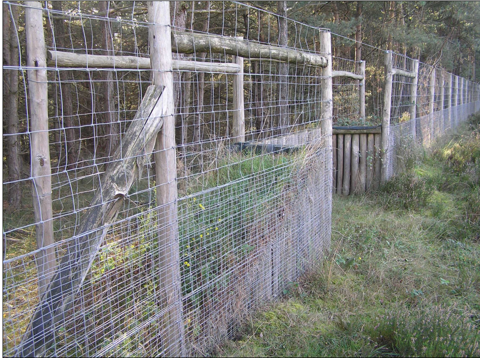
Foto 42. Fotol kujutatud ja Belgias kasutusel olevat tagasihüppekohta võiks täiendada kaldpinna laugemaks muutmisega ja selle aluse tühjaks jätmisega. Pole siiski selge, kas se hoiaks tee poole hüpped ära.
