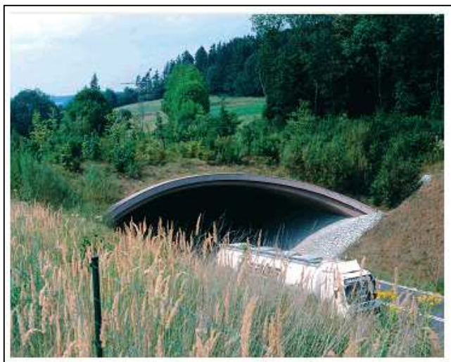
Foto 18. Piireteta ülepääs Schwarzgrabenis Lõuna-Saksamaal (B31, uus, 50 m lai, kombineeritud kohaliku teega), tihedalt kaetud põõsaste ja noorte puudega, kuna see peab ühendama piirnevate alade metsaelupaiku Foto autor V.Keller.
