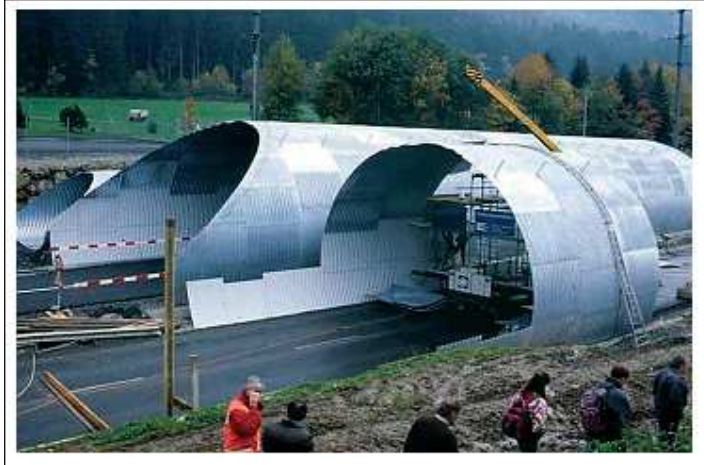
Foto 30. Šveitsis, Schindellegi's kasutati olemasoleva tee laiendamisel 40 meetri laiuse ülepääsu rajamiseks gofreeritud terasest mooduleid. See võimaldas liiklusvoo säilimist kogu ehituse vältel ühe niidi laiuses (Foto autor O. Holzgang).
