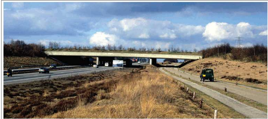
Foto 24. Tertlet'is, Arnhem'ist põhjas (Hollandis) paikneva ülepääsu külgsuuna näitab sirgeid betoontalaseid. Ka maantee tasapind on siin viidud ümbritsevast maastikust madalamale, et säilitada ülepääsu tasapinnaline sidusus ümbritseva maastikuga (Foto autor V. Keller).
