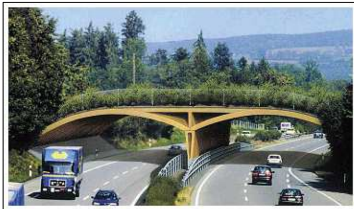
Foto 29. Puitülepääse on tänaseks Euroopas ehitatud väga harva. Prantsusmaal kujunesid ühel sellisel suurimaks probleemiks kõrged hoolduskulud. Kõrvalolev fotomontaaž Šveitsist kujutab, milline võiks välja näha tänapäevane puitülepääs (Illustratsiooni autor Marbach & Marbach, Eich, Copyright Swiss Ornithological Institute).
