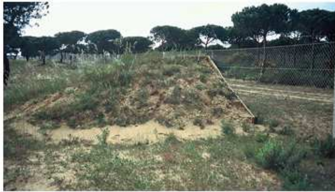
Foto 45. Sama Lõuna-Hispaania piirkonna tagasipääsukoht, mida kasutavad juba paljud loomaliigid (Foto autor: H. Bekker). Meie tingimustes kasutaksid taolist ja järgnevalt kujutatud väljapääsu nt ilves, väikekiskjad, võimalik, et metskits, kõrgusest olenevalt pole välistatud kasutamine teiste sõraliste poolt.
