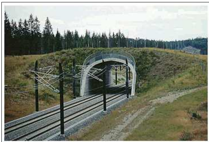
Foto 24. Tertlet'is, Arnhem'ist põhjas (Hollandis) paikneva ülepääsu külgsuuna näitab sirgeid betoontalaseid. Ka maantee tasapind on siin viidud ümbritsevast maastikust madalamale, et säilitada ülepääsu tasapinnaline sidusus ümbritseva maastikuga (Foto autor V. Keller).
