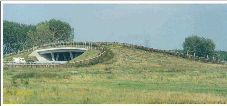
Foto 21. Fotol toodud näitel Ungaris ei ole kiirtee lõigatud ümbritsevasse maastikku, vaid paikneb sellega tasapinnas. See tõttu on ka ökodukt tõstetud teise tasapinda. Tarad suunavad loomi piki teeservi ülepääsule (Foto autor P. Farkas). Ka siin näeme lisapiiret ohutute
