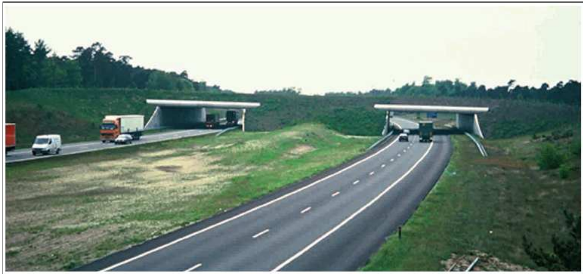
Foto 22. Loomade ülepääs Harm van der Veen (Kootwijk, Holland), mis on ehitatud 1998. aastal üle kaheniidilise laia haljasribaga kiirtee A1. See on oluline pöördepunkt Hollandis, kuna tegu on esimese ökoduktiga, mis on ehitatud üle olemasoleva maantee eraldi lahendusena (Foto autor H. Bekker).
