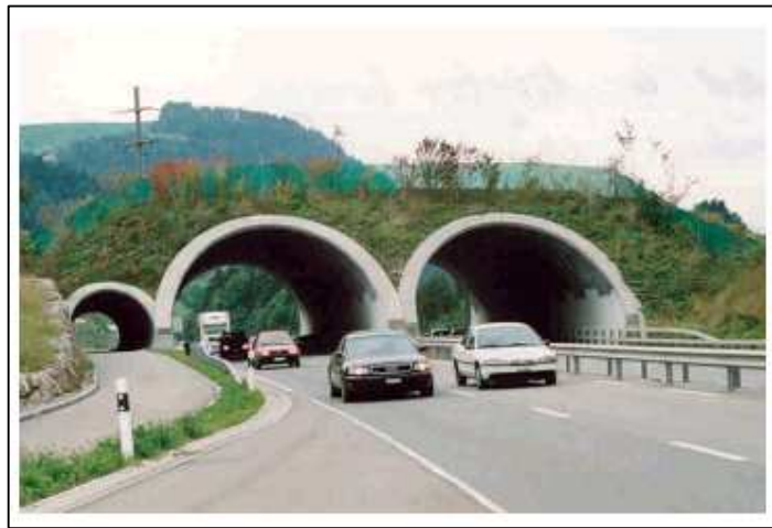
Foto 30. Šveitsis, Schindellegi's kasutati olemasoleva tee laiendamisel 40 meetri laiuse ülepääsu rajamiseks gofreeritud terasest mooduleid. See võimaldas liiklusvoo säilimist kogu ehituse vältel ühe niidi laiuses (Foto autor O. Holzgang).
