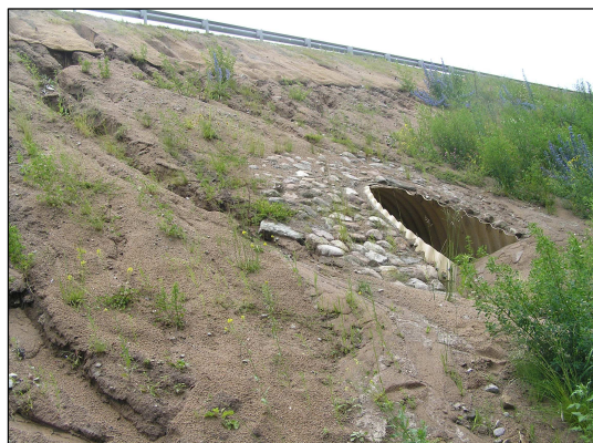
Foto 2. Tallinn-Narva mnt-l, Kolga ulukiläbi-pääsu juures on nähtav tugevate vihmade mõjul toimunud mulde erosioon. Foto: L. Klein.
