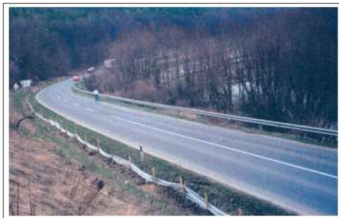
Foto 39. Tugev hele plastikkile sobib ajutise piirdena ka nt juba olemasoleva traataia kõrvale, nagu sel näitel Ungarist. Samas peavad aga tugipostid jääma kilest tee poole, ning teest eemale, konnade liikumisalale vaid sile kilepind, mis on alumises servas maasse kaevatud ( Foto autor: M. Puky ).
