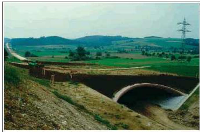
Foto 26. 80 meetri laiune maastikuühendus Hirschweg'is (B31, uus, Lõuna-Saksamaa) on kujundatud mäenõlva jätkuna üle maapinda lõigatud kiirtee. Foto on tehtud enne loodusliku piirdena istutatud põõsasheki kasvamist. Olenemata sellest hakkasid imetajad ülepääsu intensiivselt kasutama kohe pärast pinnasega katmist (Foto autor V. Keller).
