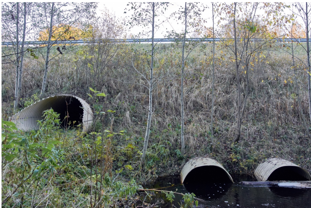
Foto 1-50,00c. Kolga jõe ääres km 49,9 on väikeulukitele sobiv läbipääs, vesi on juhitud truupidesse.
