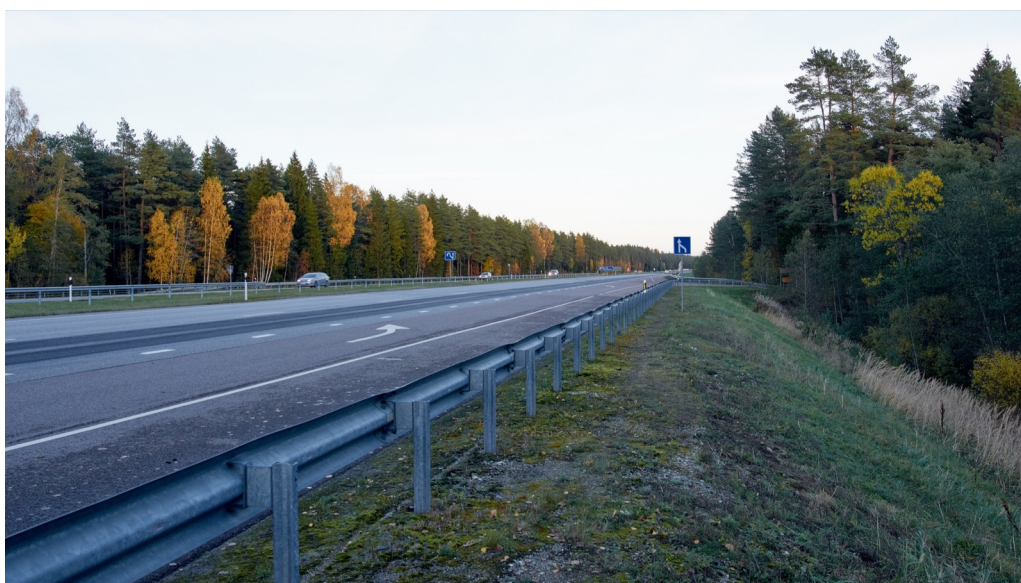
Foto 1-50,00d. Teetamm on suhteliselt kõrge ja pörkepiirdega.
