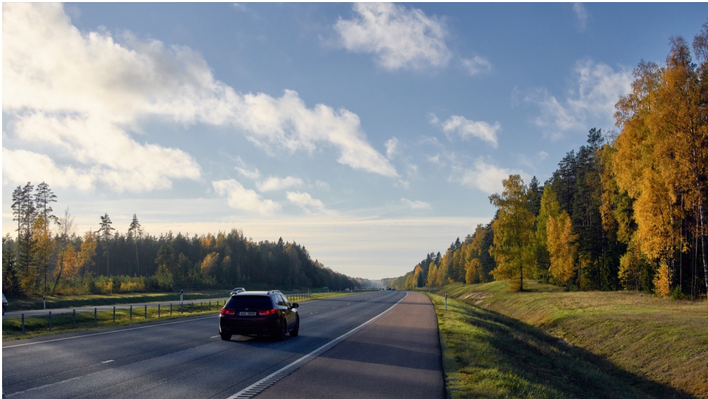
Foto 1-57,20c. Seljandik ja lauge kurv varjavad veidi nähtavust. Vaade Tallinna suunas teelõigu lõpust.
