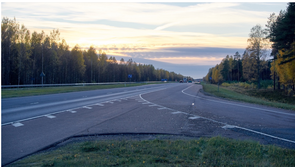
Foto 1-49,15a. Parkla väljasõit, vaade Tallinna suunas.
