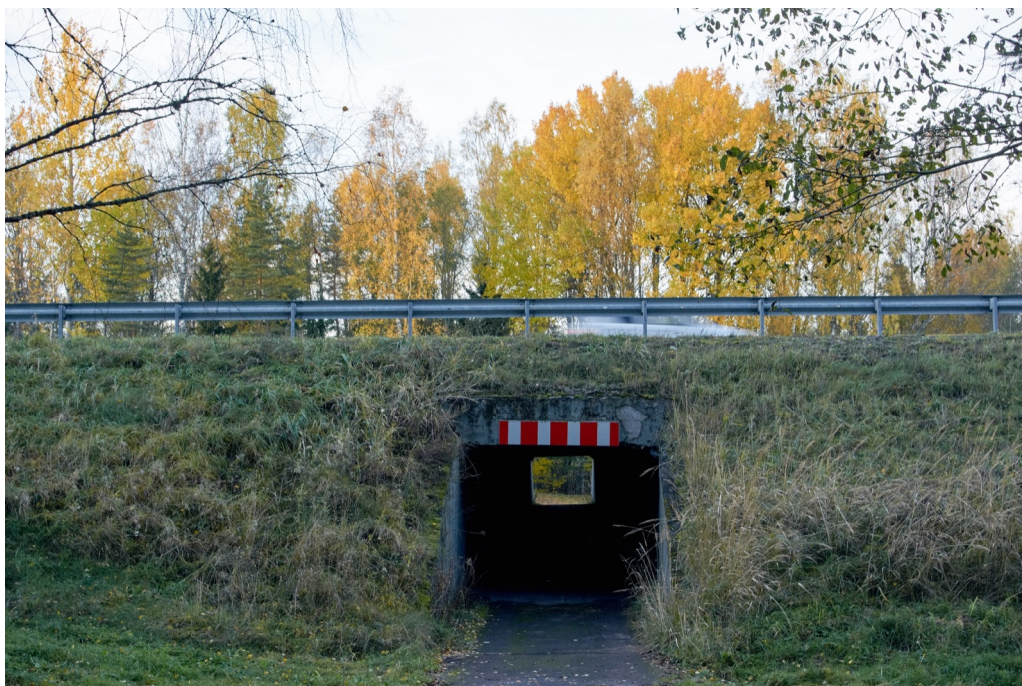
Foto 1-50,00b. Kergliikluse tunnel km 49,8.
