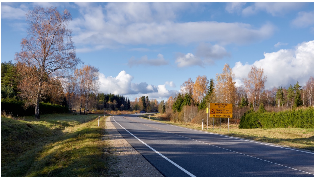
Foto 2-54,85b. Vaade lõigu lõpust Tallinna suunas.
