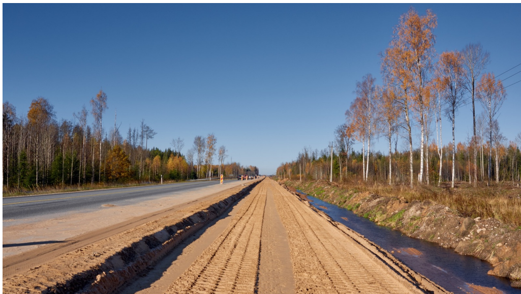
Foto 2-162,80c. Lõigul toimuvad ehitustööd 2+1 lahenduse rajamiseks.
