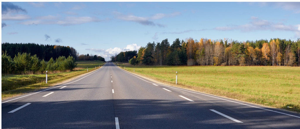
Foto2-58,50a. Vaade lõigu lõpust Tallinna suunas. Vasakul on männinoorendik.
