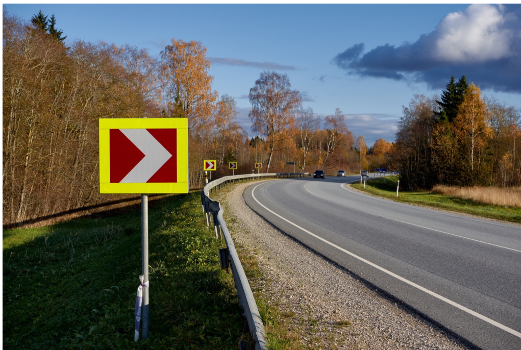
Foto 2-47,15b. Vaade lõigule Tartu suunas. Järsk kurv, kõrge teetamm ja mets sisekurvis piiravad nähtavust.
