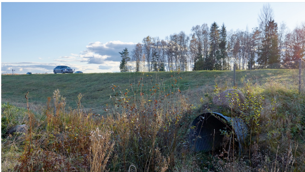
Foto 2-23,35c. Väikeulukitunnel lõigu lõpus.
