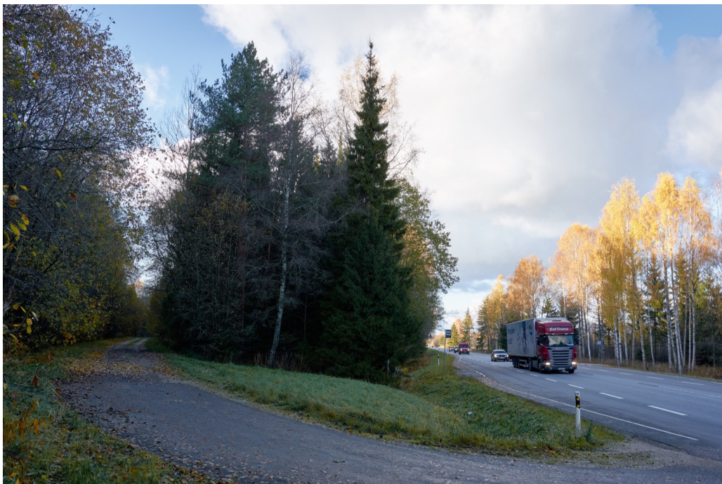
Foto 2-48,70c. Vaade lõigu lõpust Tallinna suunas. Bussipeatuse juures tuleb paremalt metsa tagant vana maantee, nõlv ja puud varjavad nähtavust.
