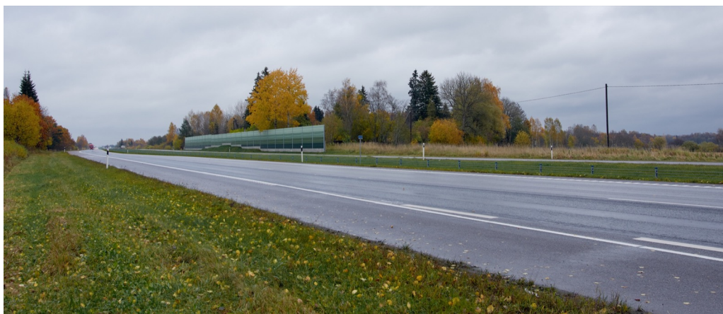
Foto 4-21,55d. Vaade lõigu lõpust Tallinna suunas. Vasakul Laiavainu talu kohal on te ääres müratõke.
