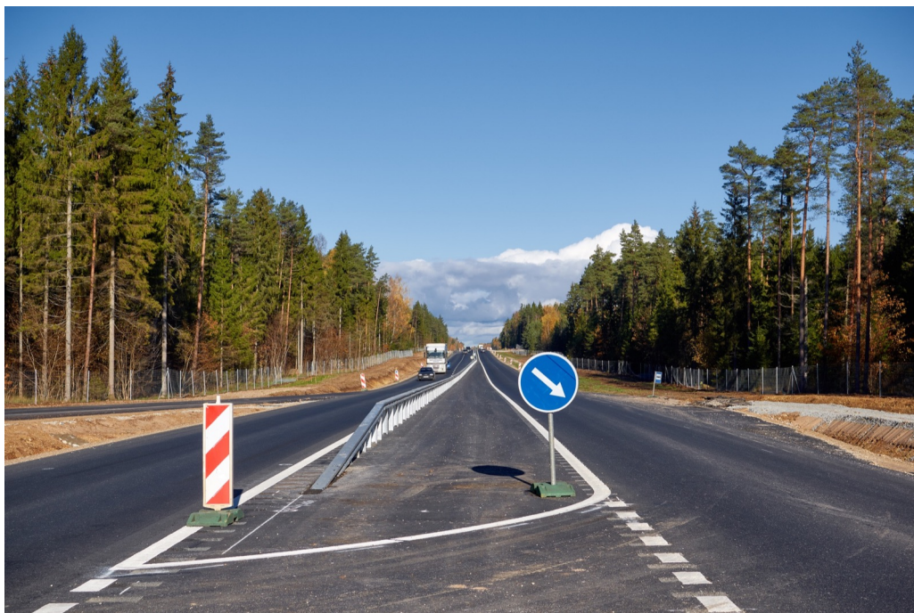
Foto 4-31,60c. Vaade lõigu lõpust Tallinna suunas. Teeääred on piiratud ulukitõkkeaiaga ja tee keskele on paigaldatud pörkepiire.
