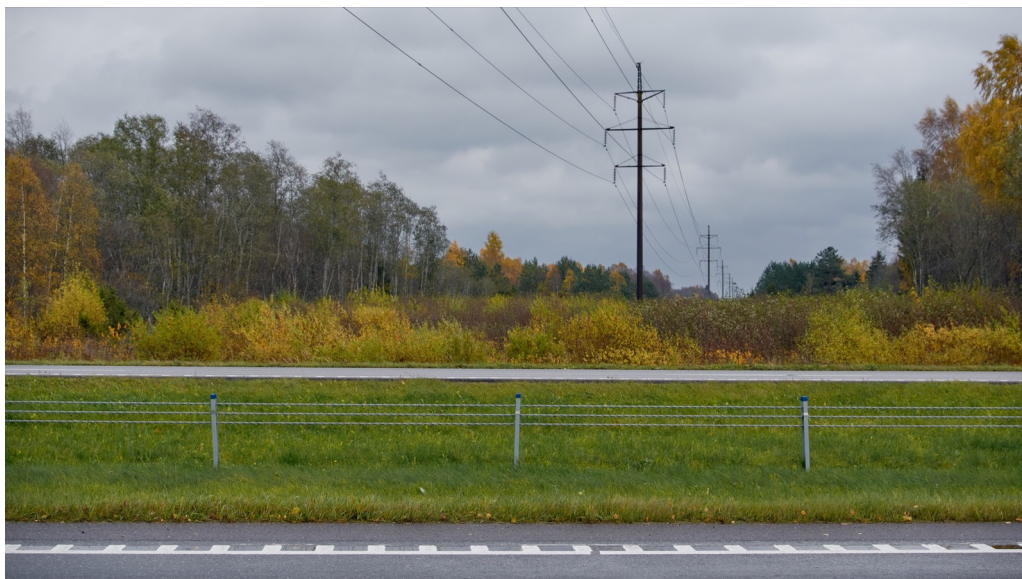
Foto 4-21,55b. Lõigu alguses ristub maanteega kõrgepingeliin.
