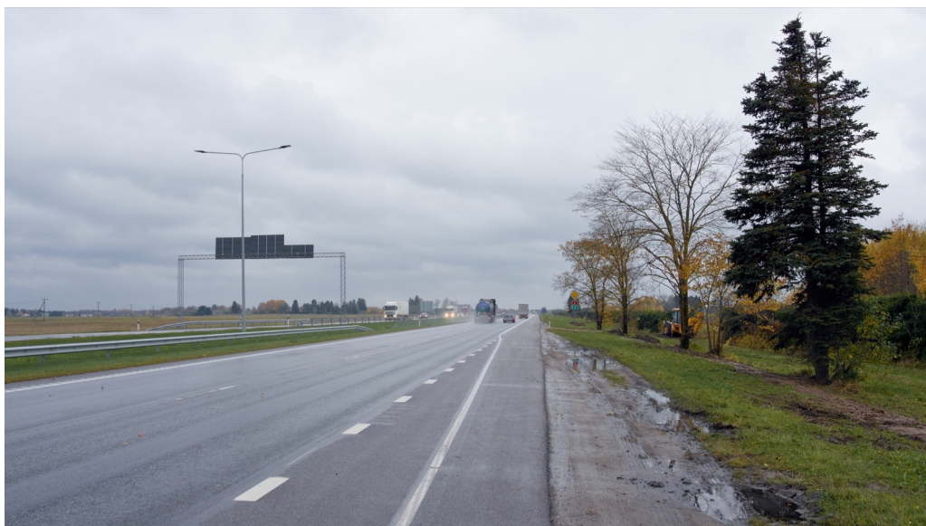
Foto 4-19,05a. Vaade lõigu algusest Pärnu suunas. Puud on kohe tee kaldas ja nende taga on aukudega kuusehekk, mis piiravad nähtavust.
