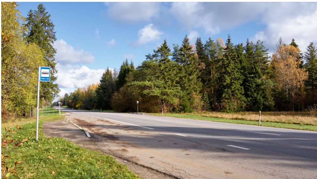
Foto 4-41,85b. Vaade lõigu lõpust Tallinna suunas. Puud on kohati teele väga lähedal ja piiravad nähtavust.
