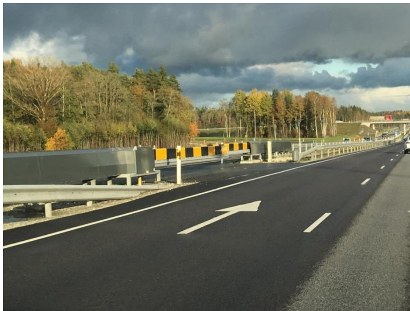
Joonis 3.10 Juuliku liiklussõlmes kasutusel olev sissesõitev väravasüsteem
