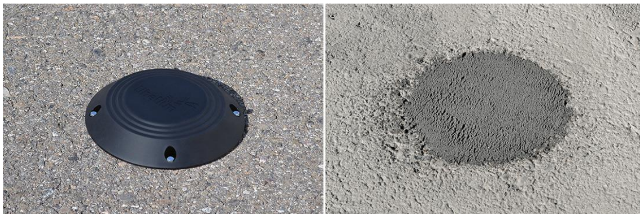
Joonis 4.6 IOT andurite paigaldusviisid: sama andur, pinnapealne ja täielikult süvistatud
