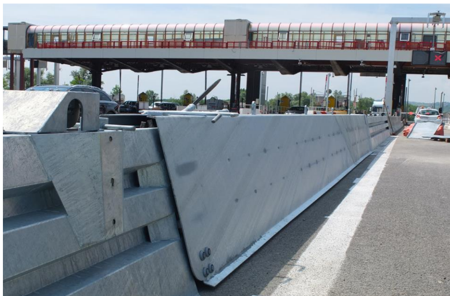
Joonis 3.11 Prantsuse ettevõtte Aximum sissesõitev väravasüsteem, mis on testitud vastavalt EN1317 nõuetele.
