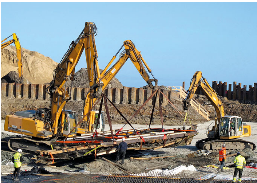
Kolme ekskavaatori koostöös viidi vrakk suure kraana haardeulatusse.
