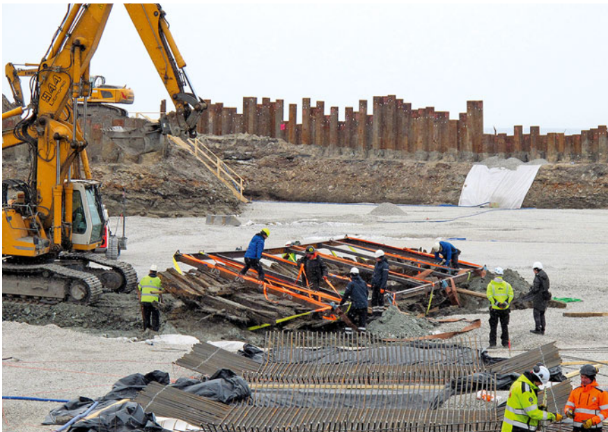
Et rasket, aga õrna vrakki saaks tõsta, oli vaja tugevat raami.
