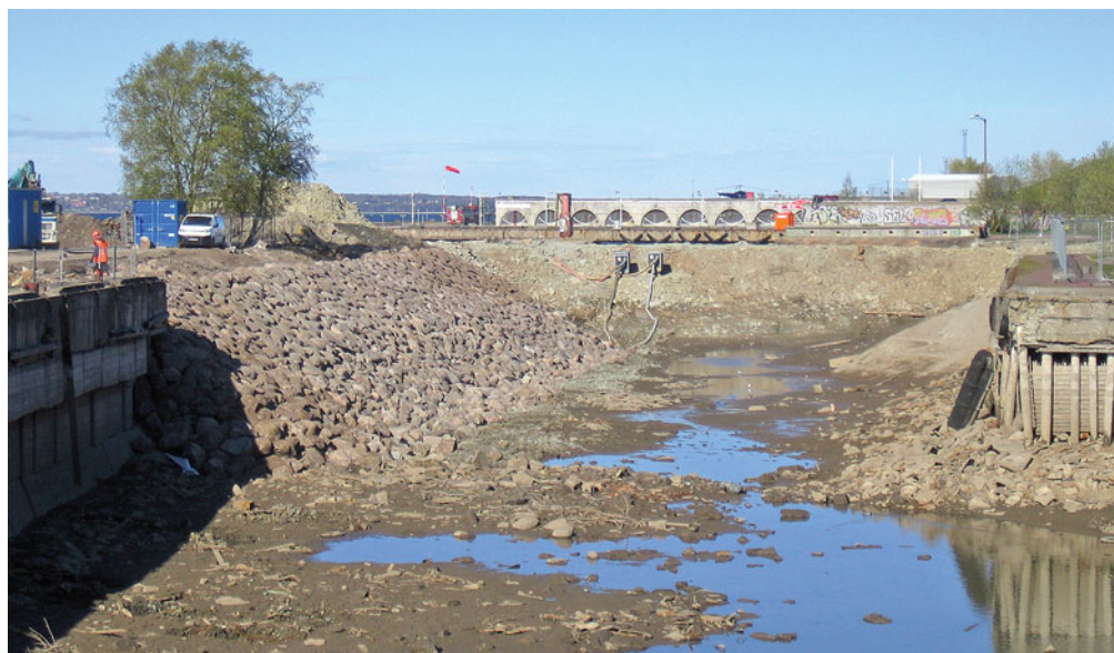
Lammutatud 6. kai asendamine nõlvakindlustisega, alles jäävad 1. ja 2. kai paremal ning 5. kai vasakul esiplaanil. Foto: Madli Vitismann
