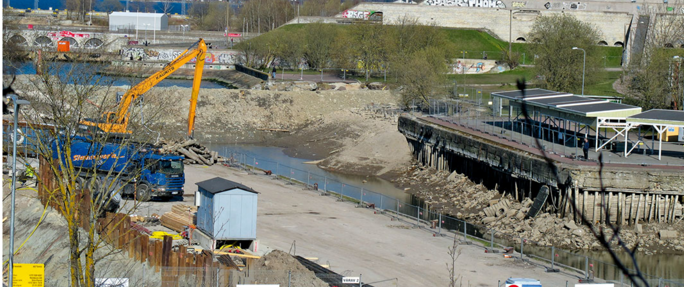
Kolm päeva pärast eelmises numbris kirjeldatud vraki lahkumist on merele tamm ette ehitatud ja Kalasadamast vesi välja pumbatud. Foto: Madli Vitismann
