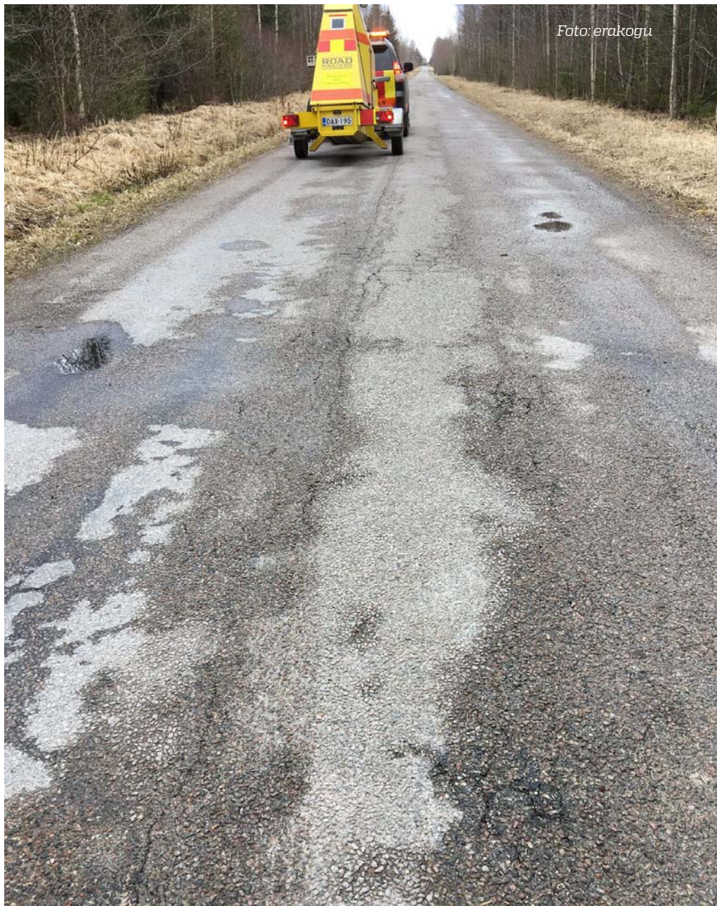
Foto 3. Defektne ja väga väikese kandevõimega pinnatud kruuskattega teelõik olukorras, kus liigniiskus on jäänud katte alla kinni.
