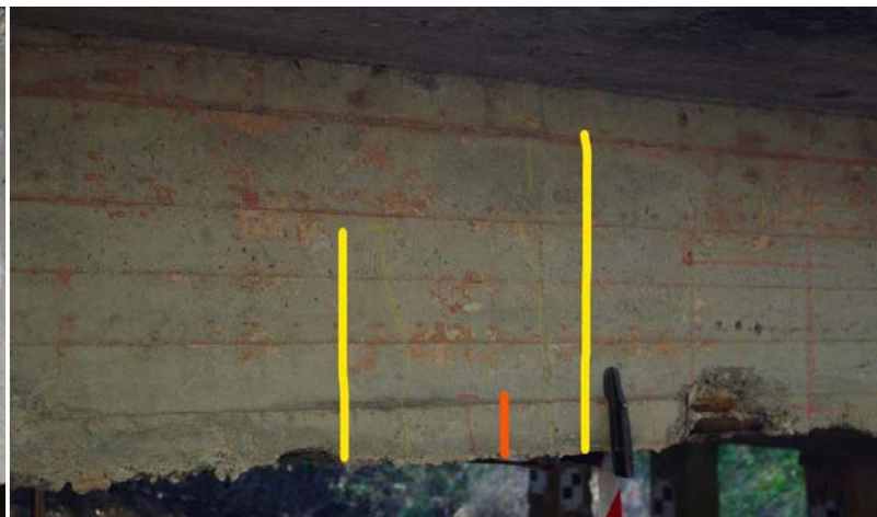
Fotod 5 ja 6. Pragude tekkimine sillataladele veoki koormuse all. Punasega on tähistatud 52tonnise veoki mõju. Kollasega on märgitud juurde tekkinud praod, kui sama veokit koormati 60 tonnini.
