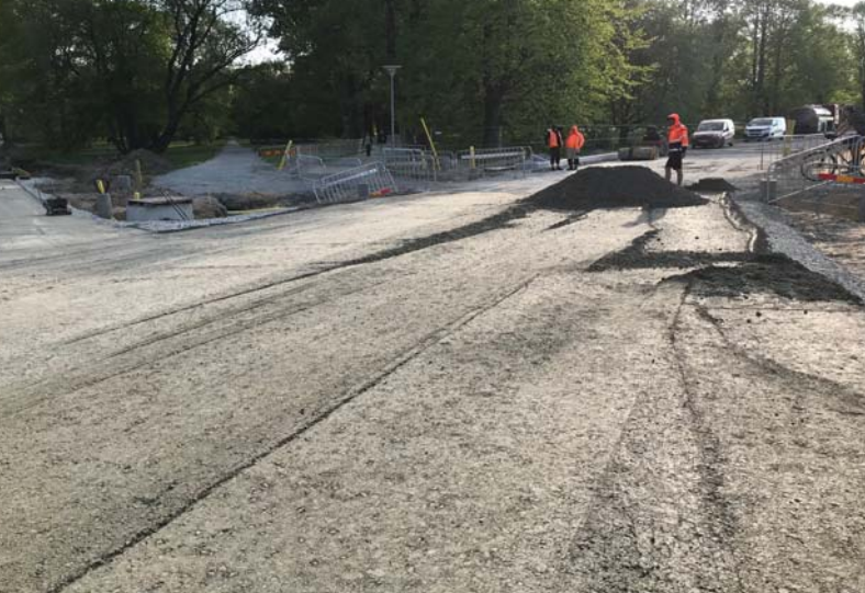
Laoturiga paigaldatud segu.
