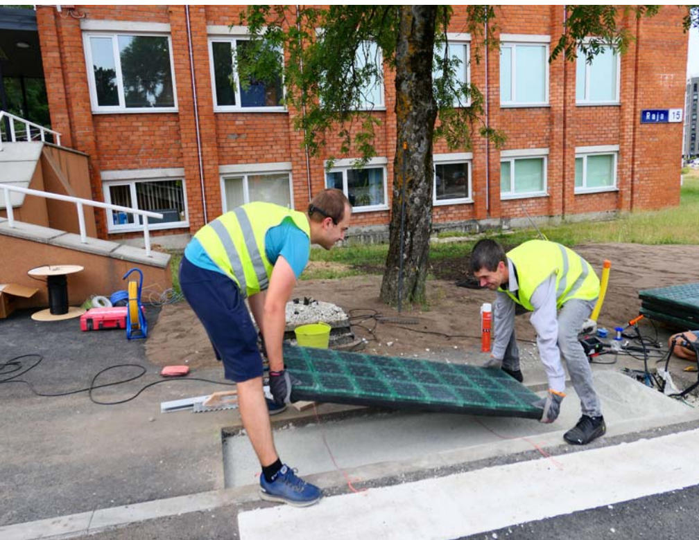
E-kivide paigaldamine Raja tänava ülekäiguraja ootealasse.
