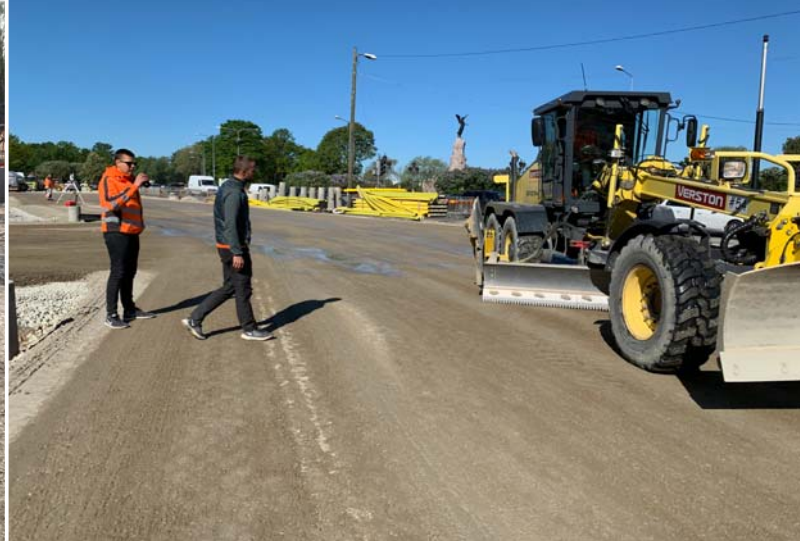
Tsementstabiliseeritud segu planeerimine greideriga.
