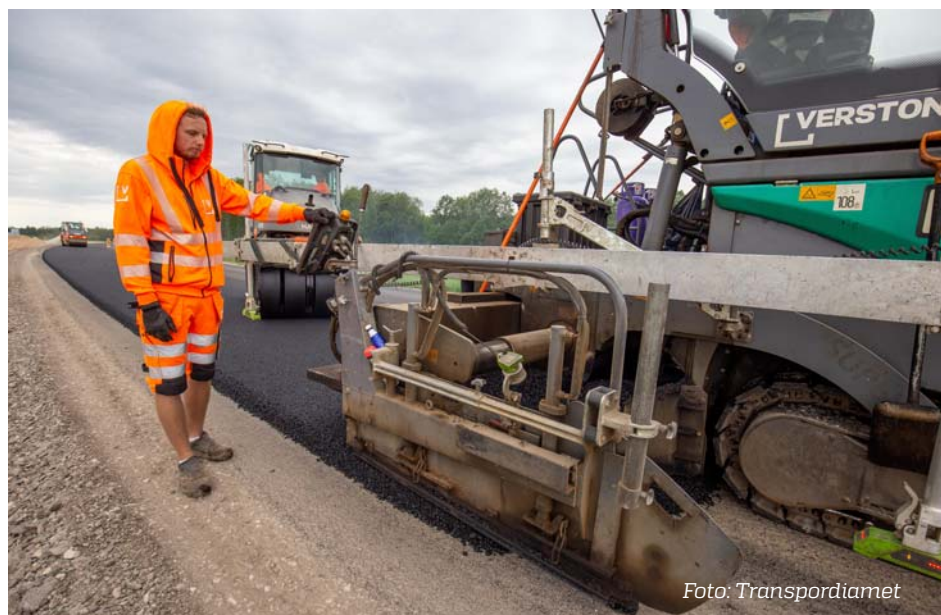
Verstoni eestvedamisel katsetatakse riigiteel nr 25 ümbertöödeldud plastjäätmete kasutamist sõidutee asfaltkattes.
