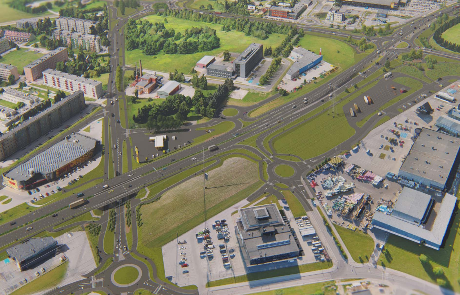
All vasakul kaks paralleelset viadukti, mis ületavad Aardla tänava. Paremal ees Tuvi tänav ja veoautode parkla.
