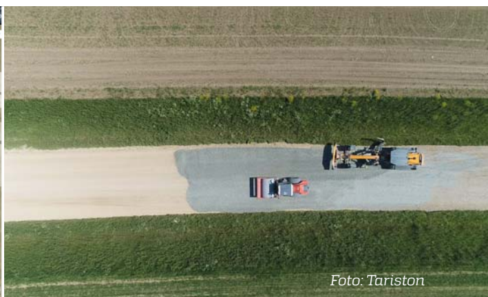
Vaade droonilt: masinjuhtimisele allutatud teehöovel planeerib killustikku.
