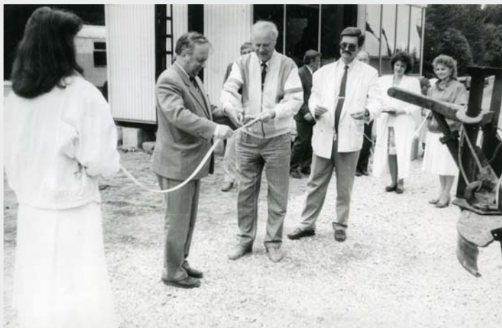
Lääne Teedevalitsuse asfaltbetoonitehase avamine 28. mail 1993 Haapsalus. Varem kasutusel olnud ja korralikult renoveeritud tehase osteti Soomest. Lindilõikamisel esiplaanil Jüri Riimaa, Lemminkäinen OY tegevjuht Arvo Kaksonen ja Lääne maavanem Andres Lipstok.
