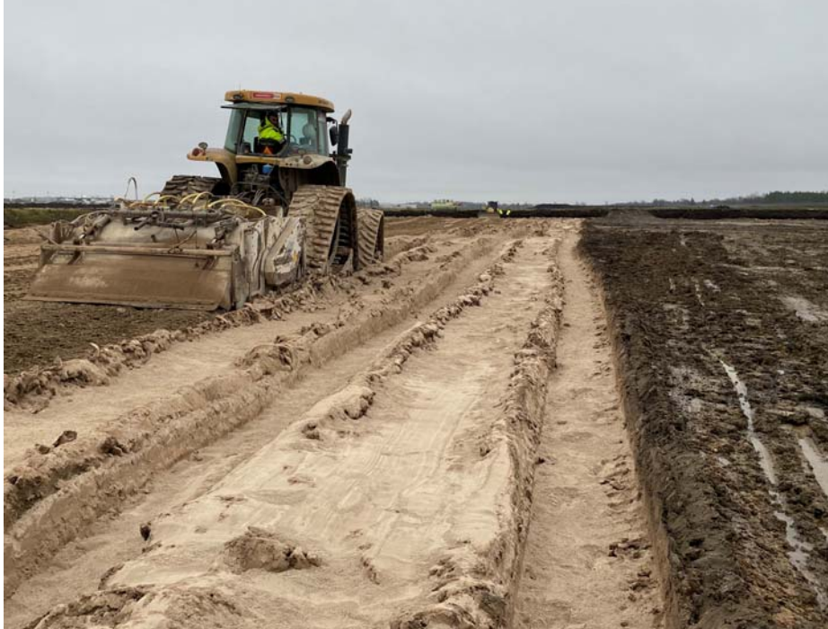
Modifitseeritud moreenpinnasega katselõigu ehitamine.
