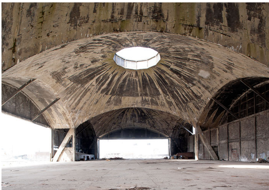
Vesilennukite angaari sisevaade enne renoveerimistööde algust 2009. aastal
