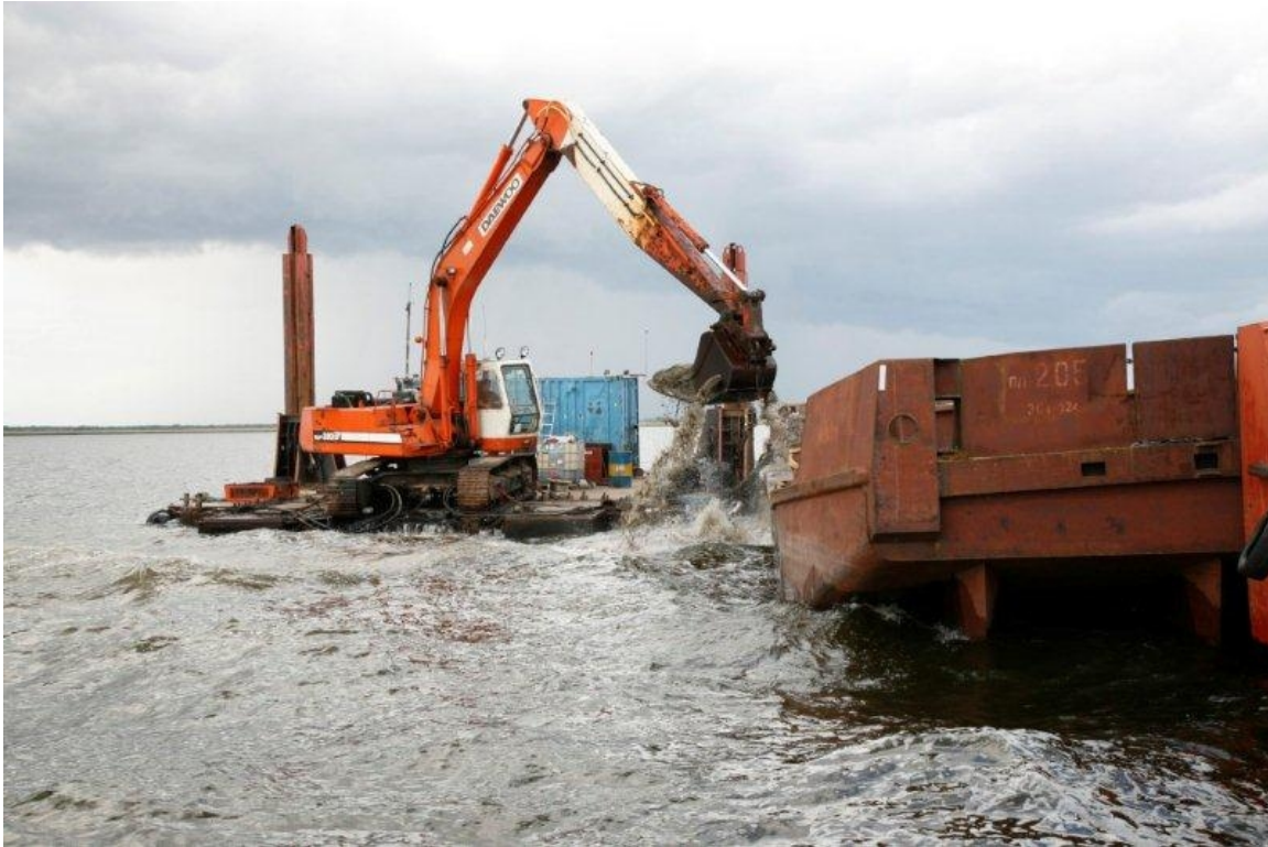
Fotol: Eesti Värava kanali süvendustööd
