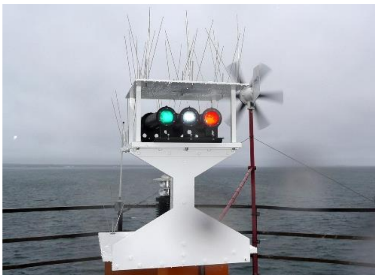
Joonis 9. Karbimadala tulepaagi laternasüsteem VLS46 – E8274 koosneb täppissektorlaternast (Vega) ja 15-kraadise pimesektoriga ringlaternast (Cybernetica AS)
