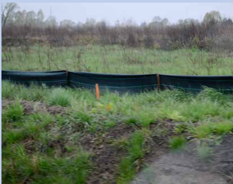
Konnade pääsu takistamiseks ehitusobjektile on paigaldatud tõke Varssavi ringtee rekonstrueerimisel.
