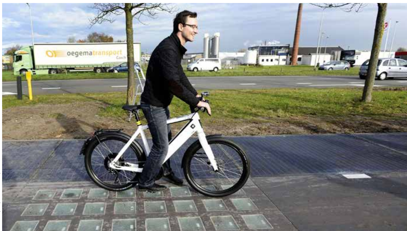
Foto 2: Holland ehitas maailma esimese päikesepaneelidega jalgrattatee Amsterdami lähisel Krommenie linnakeses 2014. aastal. Kuus kuud hiljem oli 70-meetrine katselõik tootnud 3000 kWh elektrienergiat, mis katab väikese majapidamise aastase energiatarbimise. Arvestuslikult teeb see katselõigu ühe ruutmeetri tootluseks 70 kWh aastas.
