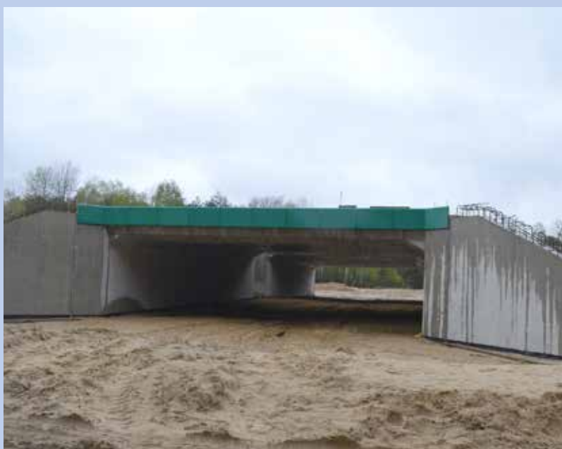
Suurulukite läbipääsuks rajatav viadukt Varssavi ringtee rekonstrueerimisel.
