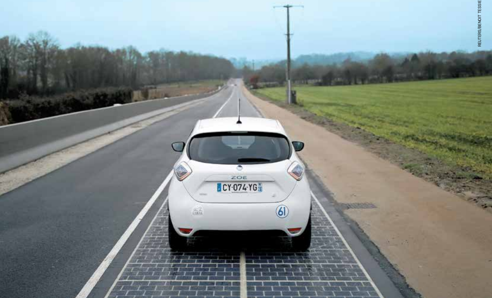
Foto 1: Prantsusmaal möödunud aasta lõpus tehtud lõunamaa oludesse sobiv e-katendi demolöök.
