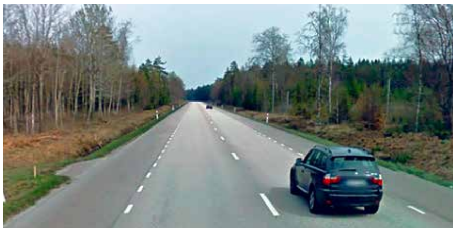
Rootsis varasemalt levinud laiade teepenaardega maantee, mille ohutuse tõstmiseks mõeldi muuhulgas välja ka 2+1 lahendus. Foto: Google Maps
