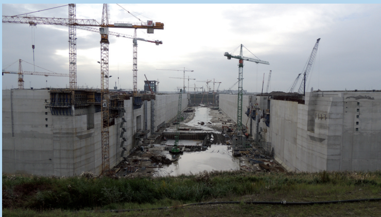
Kolme aastaga on ehitus jõudnud betoneerimisetapi lõppu
