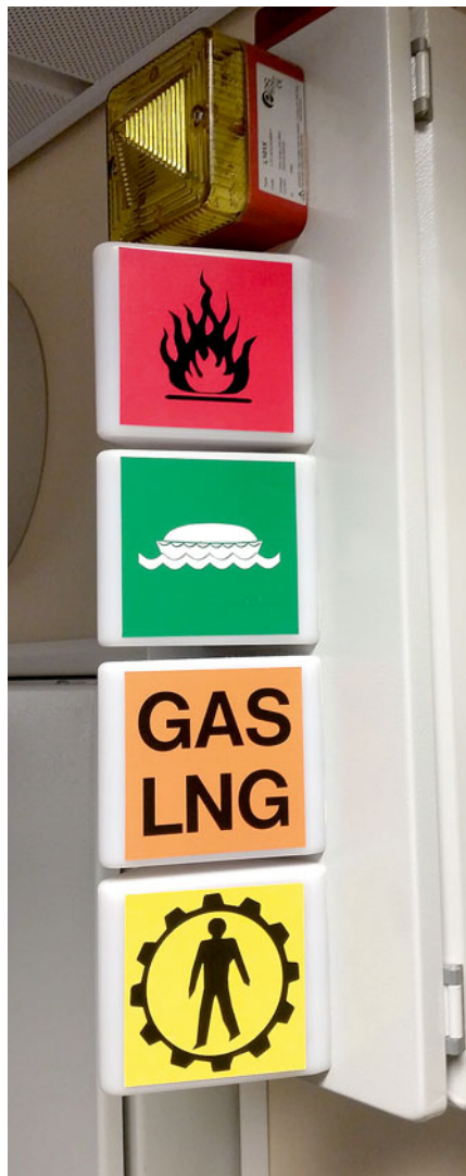
„Megastari“ masinaruumi (häire)signaalide visuaalne indikaatoritulp.
