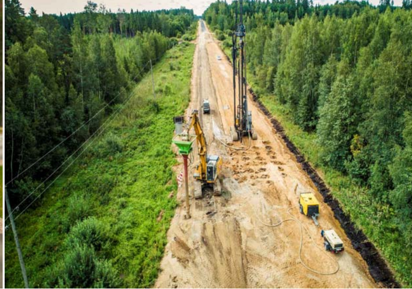
Kohtvaiade puurimine Augšligatne-Skrīveri maanteel.
