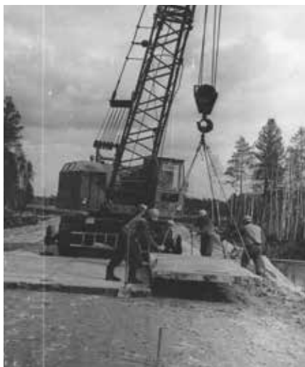
Maanteeamet korraldas tegevuse algperioodil teedeehitust ka Surgutis. Olgu mainitud, et betoonplaadid, mis alusele pandi, viidi Siberisse Eestist.
