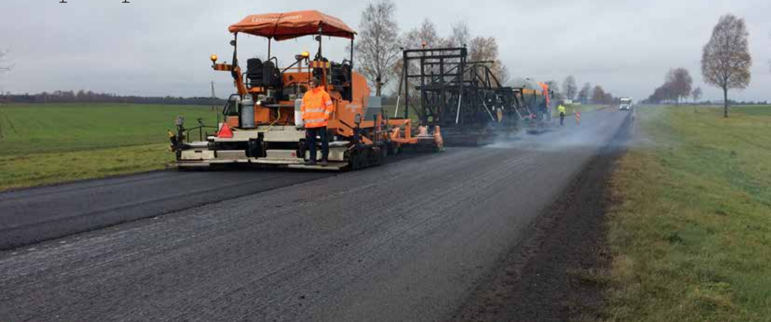
Kuumtaastamistööd 2016. aasta sügisel Tallinn–Narva maanteel
