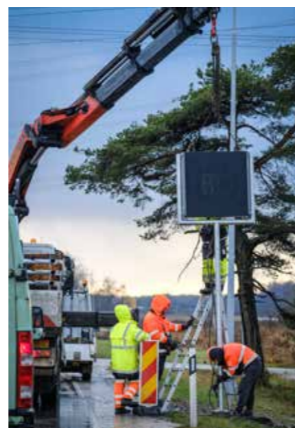
Elektrooniliste liikluskorraldusmärgide ja infotabloode paigaldamine Tallinn–Pärnu–Ikla maanteel
