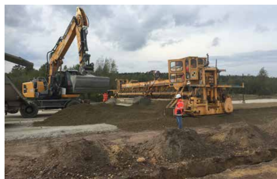
Kahekihilise konstruktsiooni ülemise kihi betooni etteandmine toimub kopaga autokastist "kaevates" ning samaaegselt materjaliga "toites" betoonilaoturi teise kihi tööorganit. Foto on tehtud Poolas.
