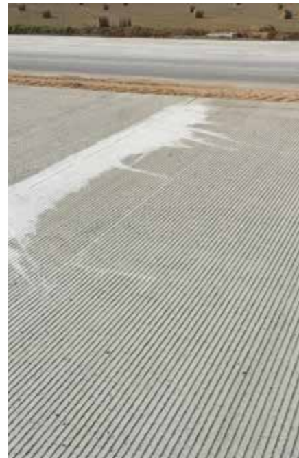
Samal objektil karestatud pealispind koos sisse-lõigatud vuugiga, löige on umbes kuu aega vana. Vuukide täitmine toimub käsitsi.
