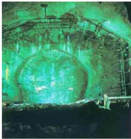
Pinnase külmutamise kui ühe erimeetme rakendamine Kluuvi kaljulõhe piirkonnas Helsingis ja malmtüübingutest tunnelitoestuse montaaž.
