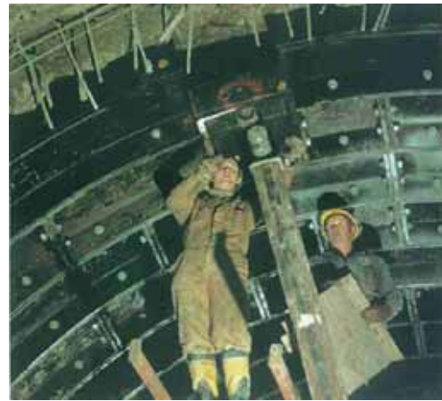
Pinnase külmutamise kui ühe erimeetme rakendamine Kluuvi kaljulõhe piirkonnas Helsingis ja malmtüübingutest tunnelitoestuse montaaž.
