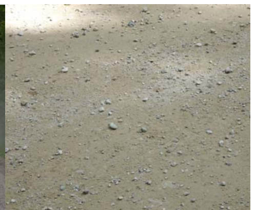
Foto 4. Katselõigu nr 6 (14,1.–14,6. km) kruuskate lähivaates. Isegi kuival ajal tundub kate kergelt märg olevat (kallis sideaine seob seega niiskust ja tolmuosakesi).
