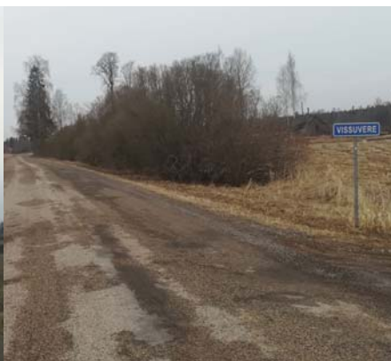
Foto 6. Pärast kruuspinnase stabiliseerimist M10+50 TM ja LBSiga katselõigul (18,7–19,1 km) oli 2018. aasta ülevaatusel näha pindamise eraldumist (ilmselt lisandi nakkeprobleemid jms).
