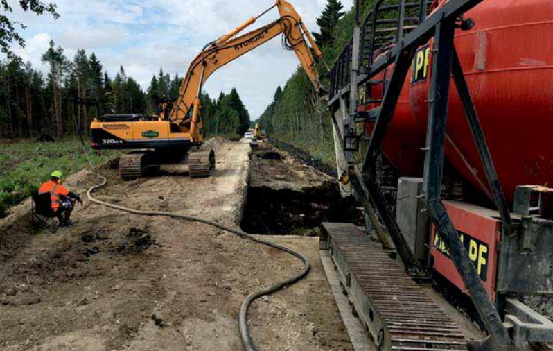
Mass-stabiliseerimine algab kasvumulla eemaldamisega, et paljandada nõrk pinnasekiht.
