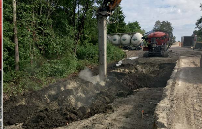
Tsemendiseguriga ekskavaator segab tsemendi turbakihi sisse vastavalt selle paksusele.
