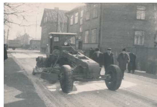
Teehöövliile paigaldatud jääpurustusseadme katsetamine Tallinnas 1958.
