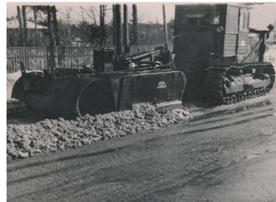
Upine jääpurustaja rootortraktori haakes katsetamine Tallinna tänavail 1957. aastal.
