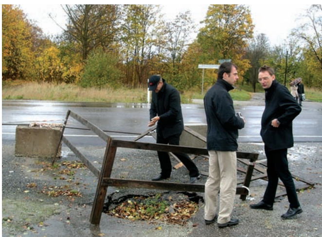
Teekatte deformatsioon ja purunemine kaevandusõõnsuse kokkuvarisemisest
