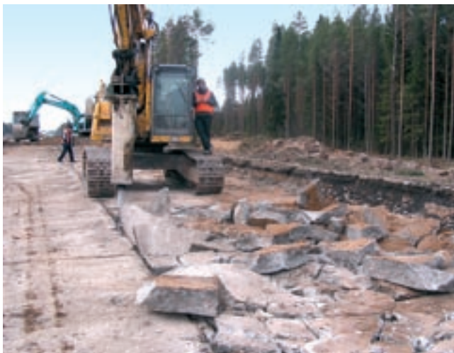
Vana betoonplaadi tükeldamine käib masinga. Foto Vaabo Annus
