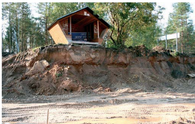
Vaibla ootekoda suurtes kõrgustes pärast tee pikiprofili parandamist Jõesuu–Oiu teelõigu remondil.
