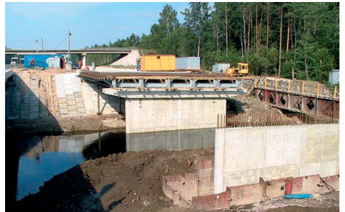
Jägala uue silla sambad valmis.
