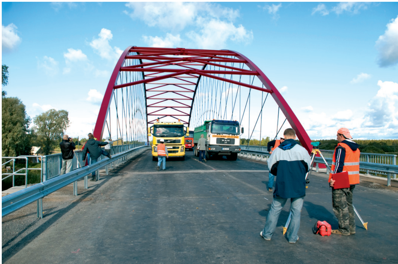
Uue silla proovikoormamine: nivelliiriga mõõdetakse autosid täis tuubitud silla läbivajumist
