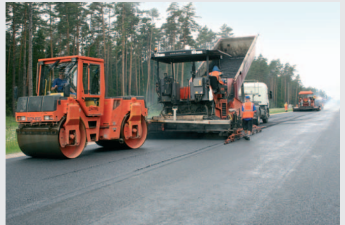
Uue kate laotamine ja kinnirullimine
