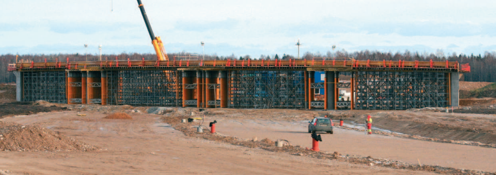
Viadukti ehitus Mäo liiklussõlmes
