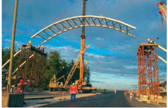
Jalakäijate viadukti kaare keskosa montaaž koos tekiplaadi karkassi paigaldusega kestis 18. juuni hilisõhtust 19. juuni varahommikuni. Jalakäijate viadukti ühe teraskaare kogumass on 41 tonni.
