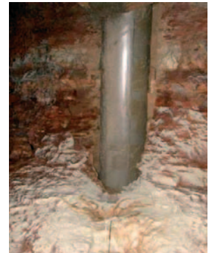
Tammiku viadukti vaivundament. 14.07.2009
