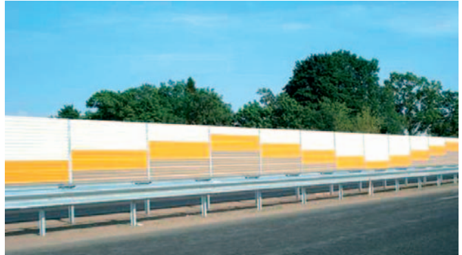
Müra- ja vaevundamentidele on rajatud müra- ja vaevundamentidele, nende kogupikkus on üle 1500 m. Teraspostide vahele on paigaldatud raudbetoonist soklipaneelid ja müra- ja vaevundamentide paneelid. Seinte kõrgus varieerub 2,8 m, 4,3 m ja 4,8 m vahel.
