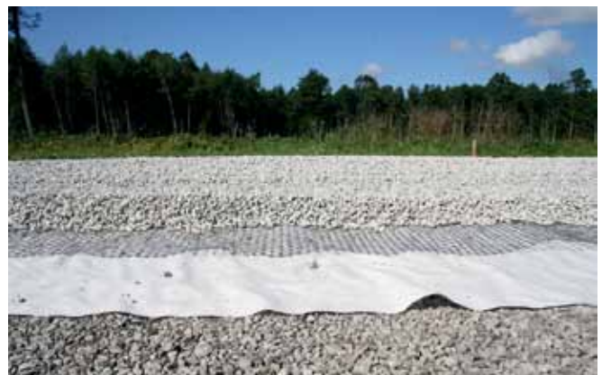
Alt üles: freesipurust aluskiht, geotekstiil, geovõrk, killustikalus...
