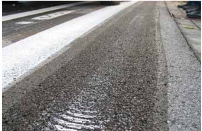
Foto 3. PeelJet iga eemaldatud termoplastmarkeeringust jäänud fantoomjoon. Näha on erinevate töörežiimide tulemusi. Tagapool on joon täiesti kadunud
