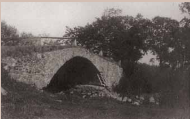
Foto 7. Erakordselt järsu tõusuga raudkivivundamentidel Vastseliina paevõlvsild lammutati 1935. aastal, sest selle ületamine oli muutunud eluohtlikuks. Foto Eesti Arhitektuurimuuseum
