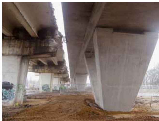
Pildil vasakul oleva vana viadukti lammutamine käib (nov 2012) ja sealt enam üle sõita ei saa alates 6. novembrist 2013, parempoolne uus viadukti pool on juba kasutuses. Teine pool koos pealesõitudega peaks lepingu järgi valmima 2013. aasta novembris. Tõenäoliselt juhtub see siiski varem, sest teise viadukti vundamendid on tänaseks kõik valatud ja isegi hull talv ei tohiks töövõtja plaani segi ajada.
