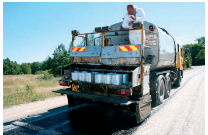
Colas Ltd kiudpindamismasin 25. juulil 2006 Jõelähtme-Kemba teel töös
