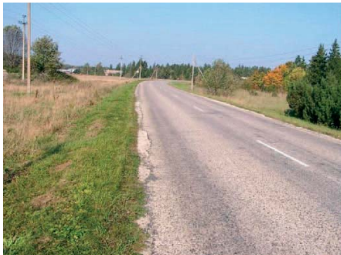
Harku-Rannamõisa põlevkivituhaga stabiliseeritud ja pinnatud tee, mis on veel praegu heas korras.
