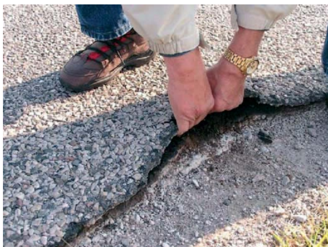
Foto ülal: Sagedane nähe, kus pindamiskiit ei ole piisavalt nakkunud stabiliseeritud kihiga.
