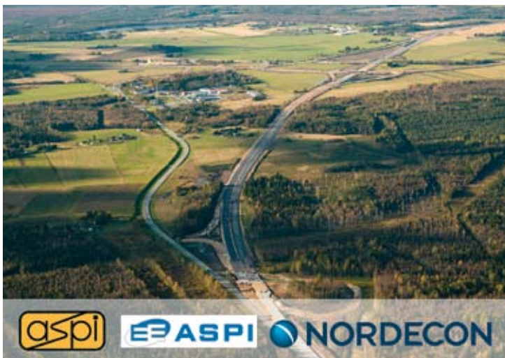
Õhufoto Mäo ümbersõidutee ehitusest. Foto: AS Nordecon Infra
