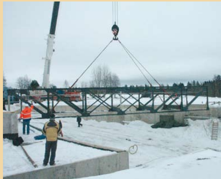
Raudfermidest silla paigaldamine Maanteemuuseumi välialadele.
