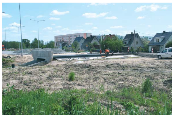
Jalakäigutunneli ehitus Ehitajate teel.
