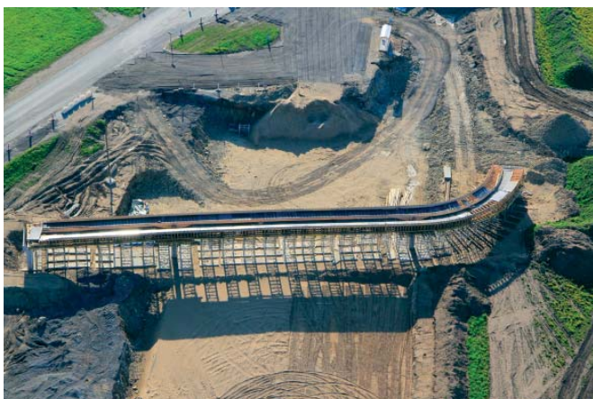
Haljala liiklussõlme ehituselt. Vaade kergliiklusviaduktile. Foto: Vladislav Krõmski 21.05.2012.
