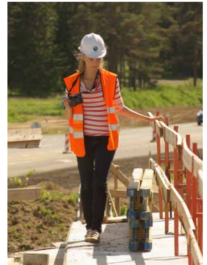
Luige eritasandilise ristmiku ehitusobjektil, ehitusjärgus olevad viaduktid. Foto: Algis Vaitekunas.
