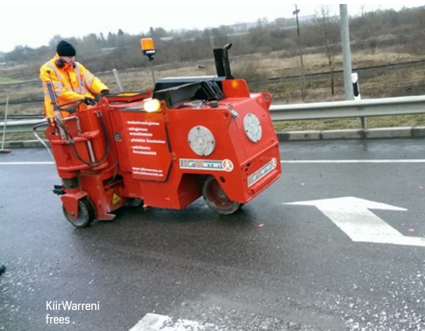
Ajutine liikluskorraldus Tallinnas Järvevana teel. (Näitab ilmekalt, kuidas enne ajutise kollase joone teostamist tuleks alaline märgistus kas kinni katta või eemaldada.)
