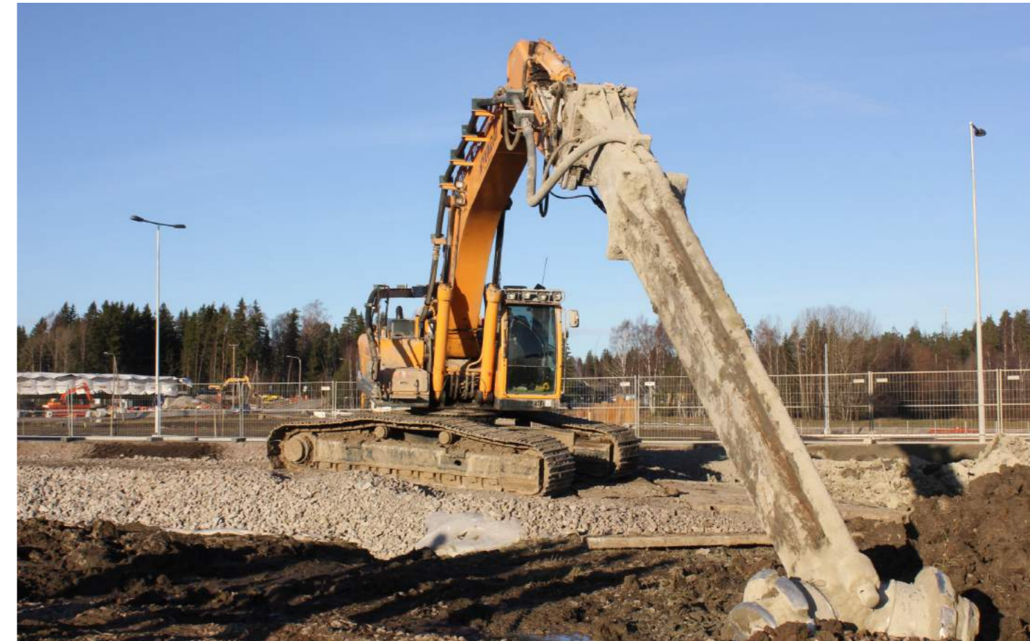
Turbapinnase mass-stabiliseerimine sügava kaeviku sulundseinte paigaldamiseks. Foto: Timo Tsefels
