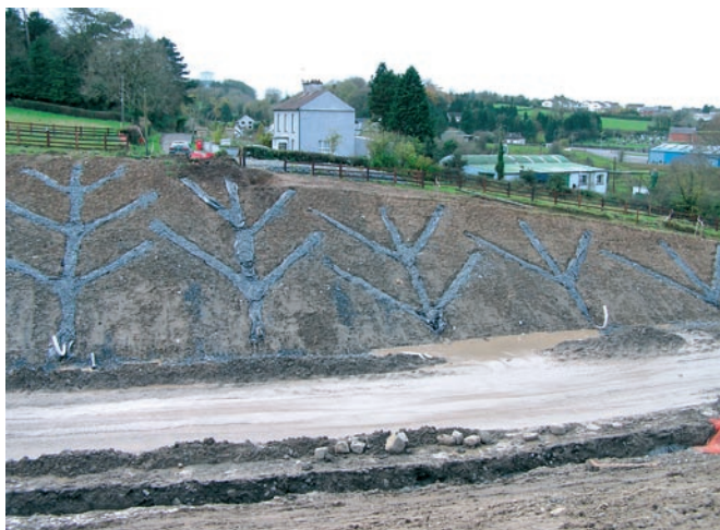
Monaghani linna möödasõidutee ehitus. Näha on ulatuslik drenide süsteem süvendi nõlvadel. Foto: Raul Vibo
