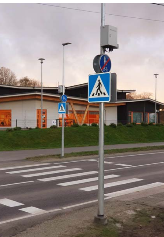
Riistvara on modulaarne ja seda saab paigaldada juba olemasolevale ülekäigurajale.
