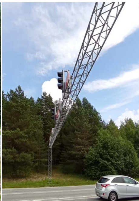
Punased märgutuled kõrguspiiraja külge paigaldatud foorides keelavad juhil edasi sõita.
