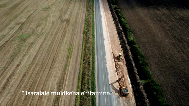
Ettevalmistustööd truubi paigaldamiseks.
