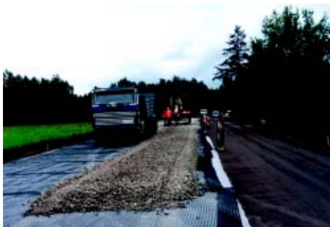
Terasvõrk asfaldi alla
