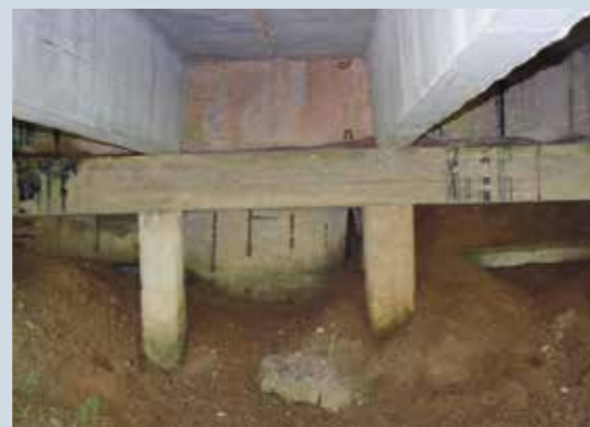
Vaade vaivundamendile rajatud kaldasambale, kus on näha betooni murenemist, armatuuri korrosiooni ja koonuse uhtumist.
