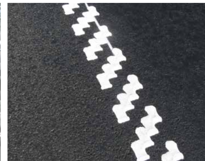
Struktuurse märgistuse eelised tulevad välja vihmas ja pimedas, sest nende valguspeegelduvus on oluliselt parem kui tavalistel joontel.
