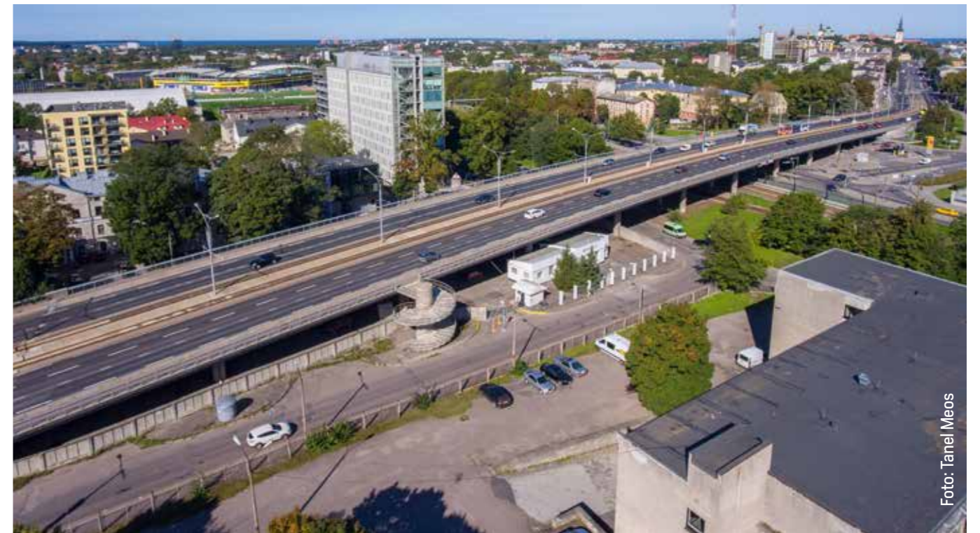
Tallinnas Pärnu maanteel kõrguv Egerti-tüüpi läbijooksva talaga plaatsild, kus tala pikkus on muljetavaldavad 300 meetrit.
