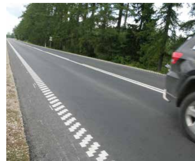
Struktuurse märgistuse eelised tulevad välja vihmas ja pimedas, sest nende valguspeegelduvus on oluliselt parem kui tavalistel joontel.
