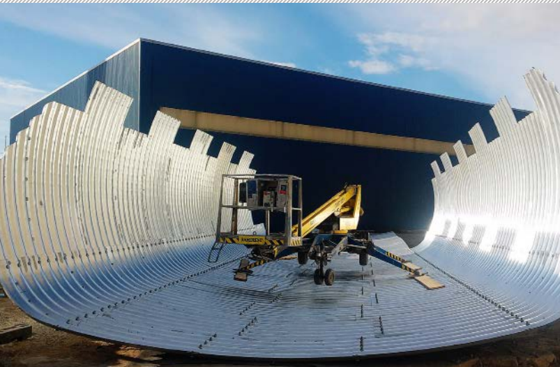
Noblessneri jalakäijate tunnel Tallinnas Kalaranna tänava all. Ehitusjärgus (vasakuul) ja valmiskujul.
