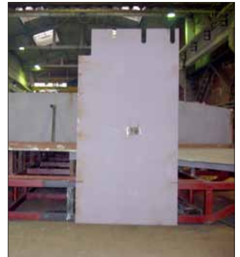
Plaat kinnitati meeskonna ruumide ja tankiruumi vaheseina külge
