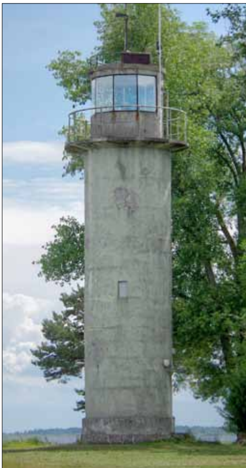
Mehikoorma tuletorn enne 2013. aastat ...
