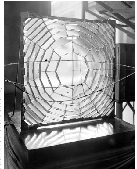
Üks esimesi Fresneli läätse paneelidest aastast 1821, paneel mõõtmetega 81x78x6 cm koosneb 70 klaasprismast
