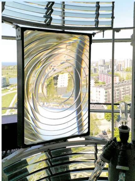
Tallinna sihi ülemise tuletorni II järgu katadioptriline aparaat, Sautter, Harle & Cie constructeurs Paris 1896
