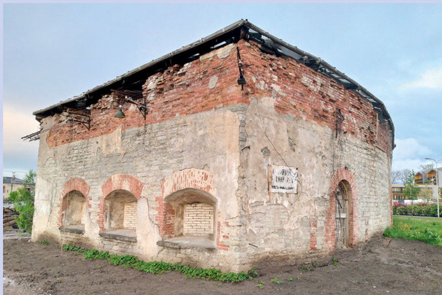
Eraldi rajatud mortiiropatarei reduudi peal asetseva kaponiiri suurtükilaskeavasid on ees (pildil paremal) ja mõlemal küljel (parem külg on pildil vasakul). Püssilaskeavasid on esiküljel ja 2. korruse kõikidel külgedel. Foto: Robert Treufeldt, 27. mai 2021
