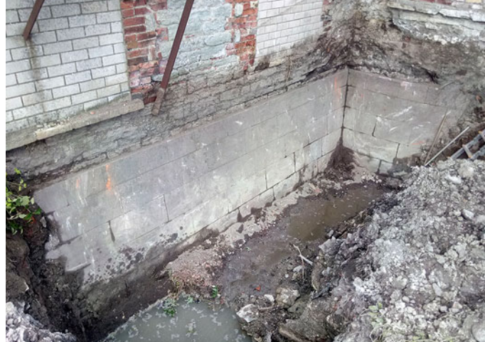
Suvel 2020 tuli uuringutel allpool praegust maapinda välja fordi goržihoone tagumise (merepoolse) osa sokli võimas tahatud graniitkividest müüritis. Kivid on arvatavasti pärit Soomest. Umbes 300 m pikkuselt on kokku umbes 2000 kivi. Foto: Robert Treufeldt, 10. juuli 2020
