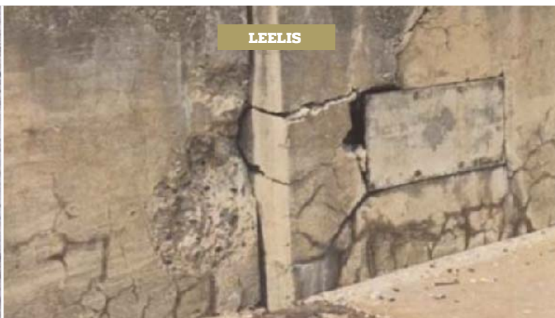
Foto 4. Leelise ja täitematerjali reaktsioonist tingitud kahjustused hoone vundamendis.
