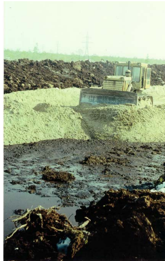
Esimesel objektil 1981. aasta suvel Pimis tuli tee muldkeha ehitada soos.
