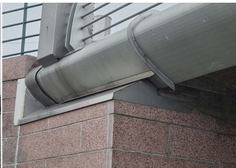
Foto 5. Cruselli vantsilla täielikult ilmastikukindel ots.
