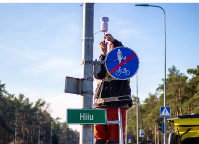
Nutikate teeilmajaamade paigaldus Tallinnas.
