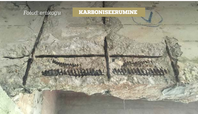
Foto 1. Karboniseerumise sügavus on silla peatalal ületanud sarruse kaitsekihi paksuse, mille tagajärjel sarrus korrodeerub ja mahu suurenemise tõttu eraldub kaitsekiht.
