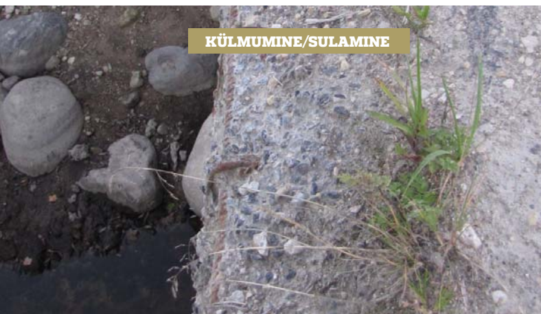
Foto 3. Betooni ebapiisava külmakindluse tõttu lagunenuid silla servapruss.
