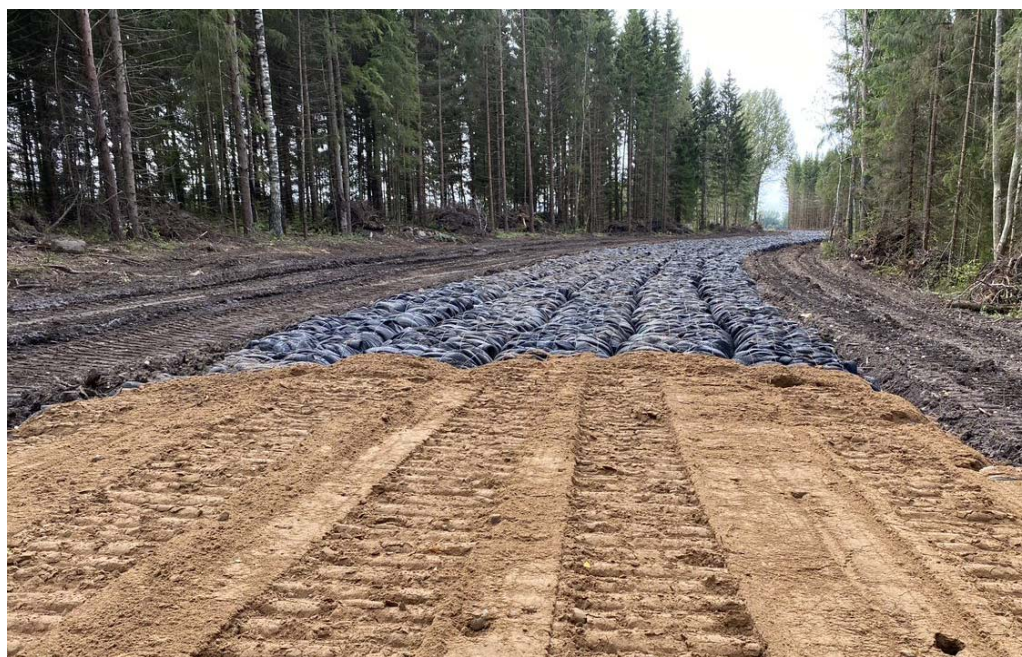
Rehviplokkide vahelised tühimikud täideti liivaga, et vältida katendimaterjali valgumist plokkide vahele.
