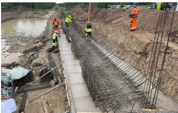
Viadukti vundamendi valamine.
