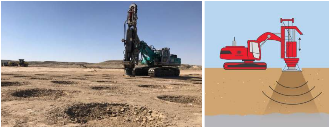
Joonised 4.23 ja 4.24. Langeva koormusega lööktihendajaid. [32]
