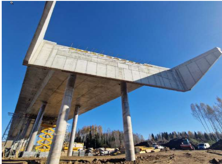
Joonis 9.1. Viadukti tiibade tagused ja alused täited jms raskesti ligipääsetavad kohad. [Foto: Kimmo Paap]
