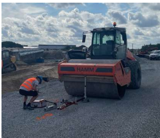
Joonis 6.5. Plaatkoormuskatse läbiviimine. [Foto: Simmo Talpas-Taltsepp]
