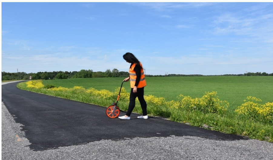
Foto 16 Katte defektide ja paranduste mõõterattaga mõõtmine
