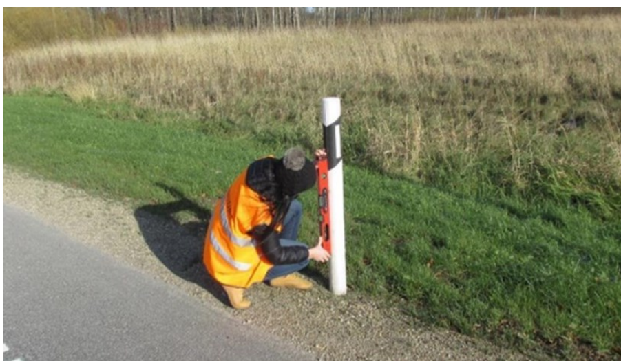
Foto 34 Märgi- ja tähispostide vertikaalsuse mõõtmine digitaalse vesiloodiga
