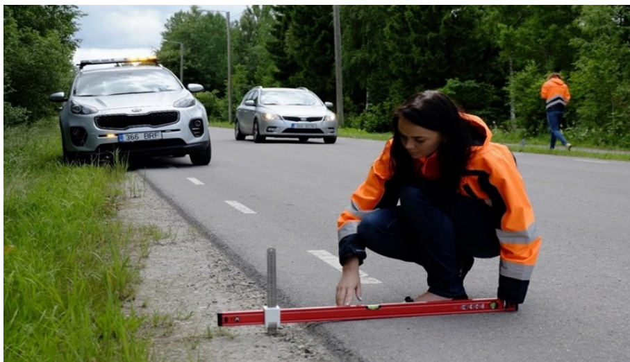
Foto 10 Teekatte ja madalama teepeenra kõrguste erinevuse mõõtmine vesiloodi ja mõõdulindiga
