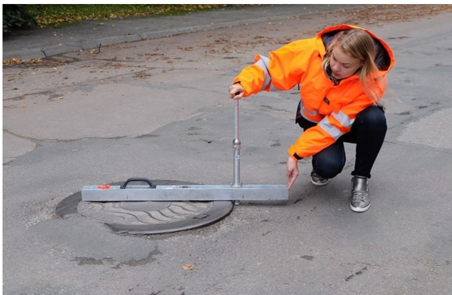
Foto 14 Teekattest kõrgema tehnovõrgu või kape kõrguste erinevuse mõõtmine aukude sügavuse mõõdikuga
