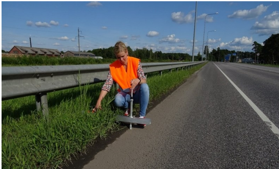
Foto 9 Teekatte ja kõrgema tugipeenra kõrguste erinevuse mõõtmine aukude sügavuse mõõdikuga
