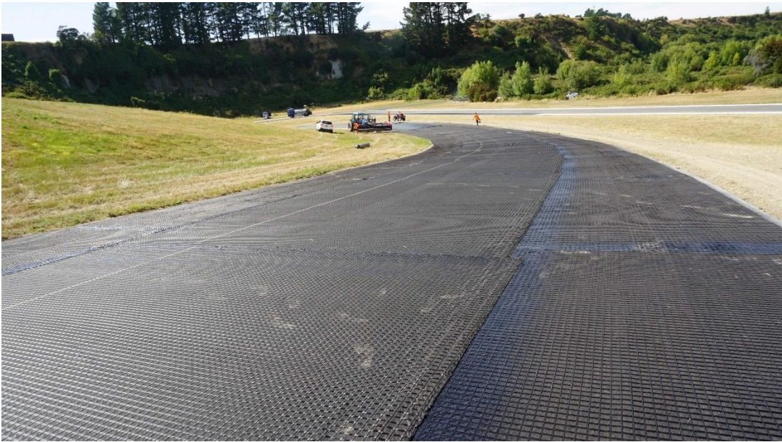
Joonis 37: Korrekselt laotatud geosünteed. 11
