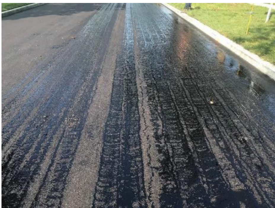
Joonis 33: Ebapiisav kogus bituumentit 7
