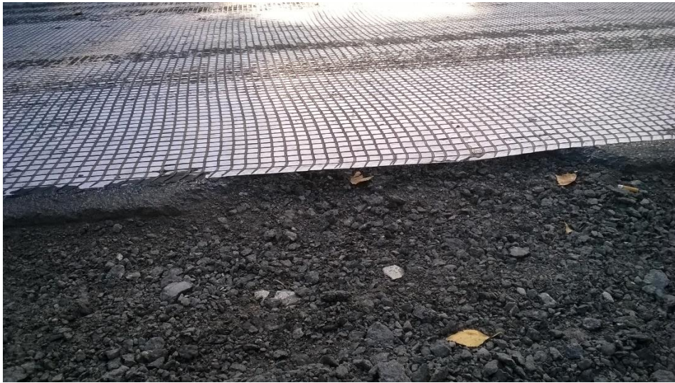
Joonis 29: Asfaldi geokomposiit on paigaldatud ebakorrektselt aluspinnale. Serv on jäänud alt tühjaks.
