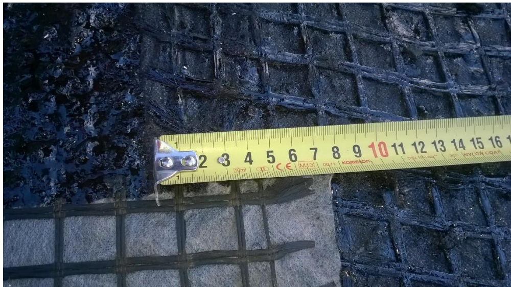
Joonis 32: Ebapiisav ülekate. Järgida tuleb paigaldusnõudeid.
