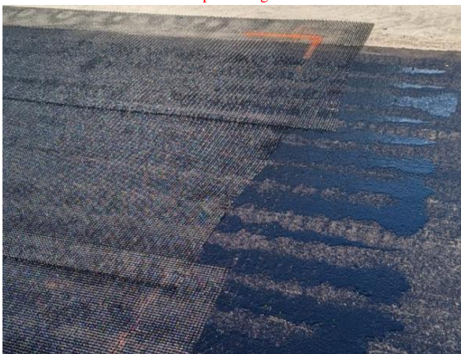
Joonis 34: Ebapiisav kogus bituumentit 8
