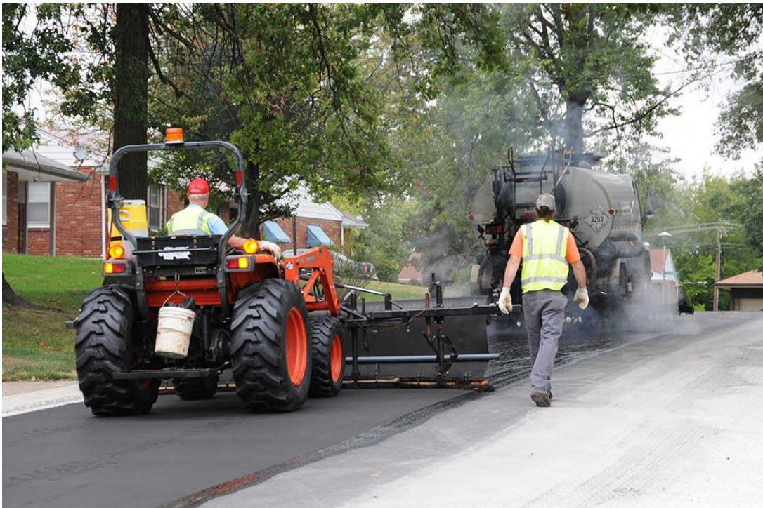
Joonis 38: Korrektne geosünteedi paigaldus. 12
