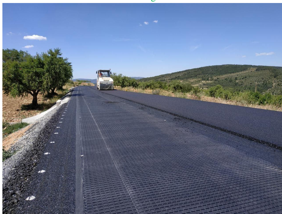
Joonis 36: Korrekselt laotatud geosüntee. 10
