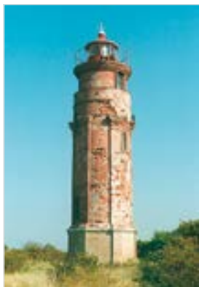
860 Sorgu tule torn
