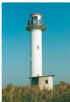
830 Pöörilau tule torn
